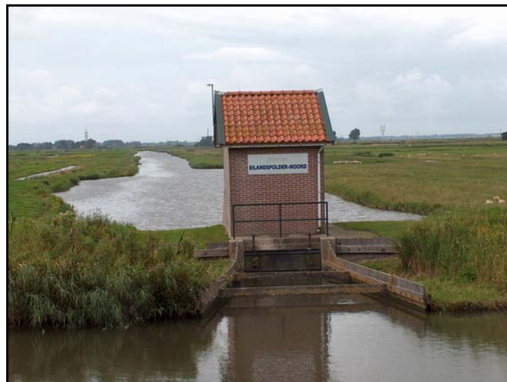
Bild 18 Modernes Pumpwerk [Foto L. Frossard]
