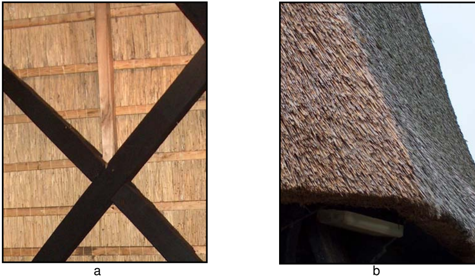
Bild 13 Poldermühle. Innenansicht (a) und Aussenansicht (b) der Wände aus Schilf [Fotos L. Frossard]
